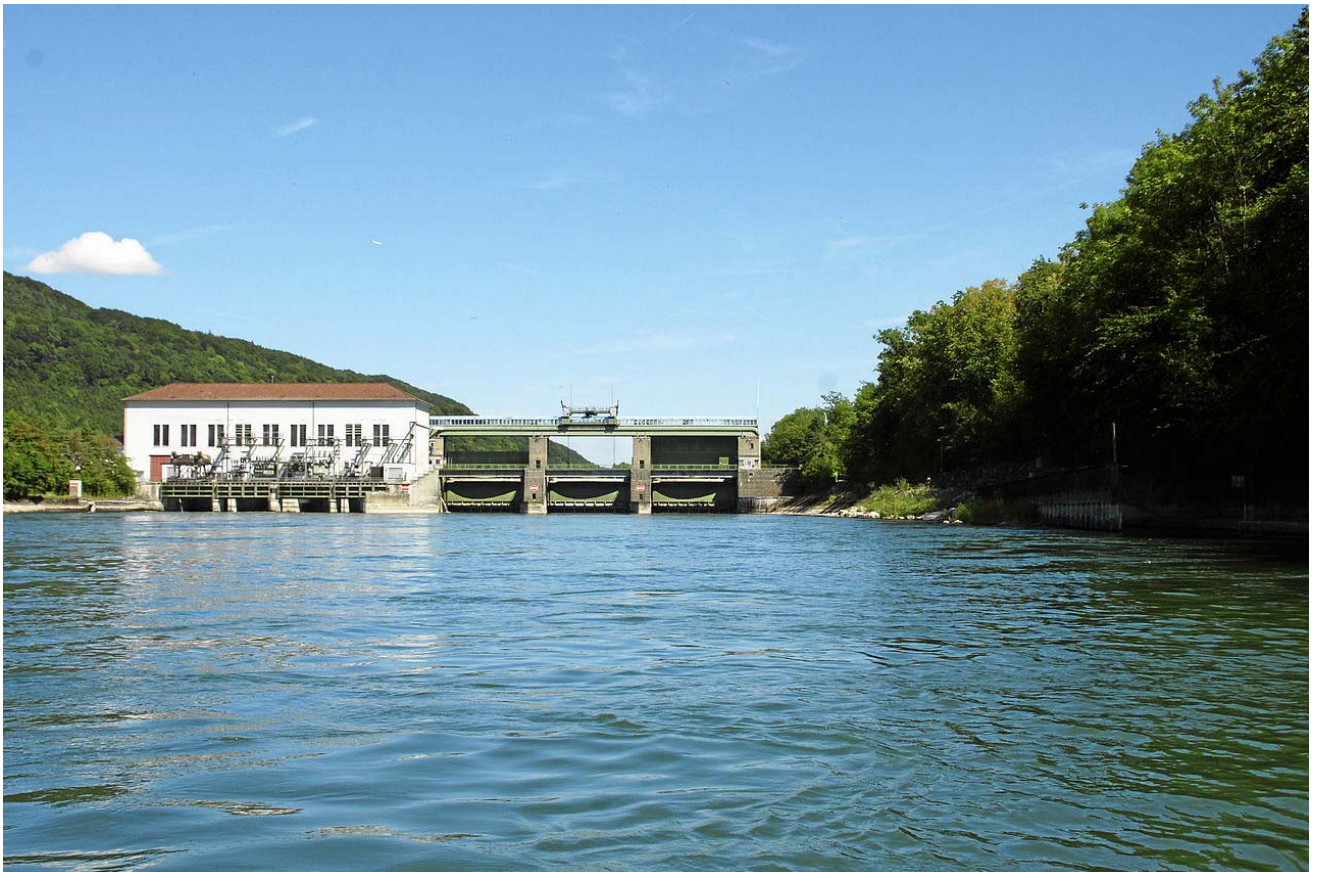
Bild: Blick vom Unterwasser zum Kraftwerk
